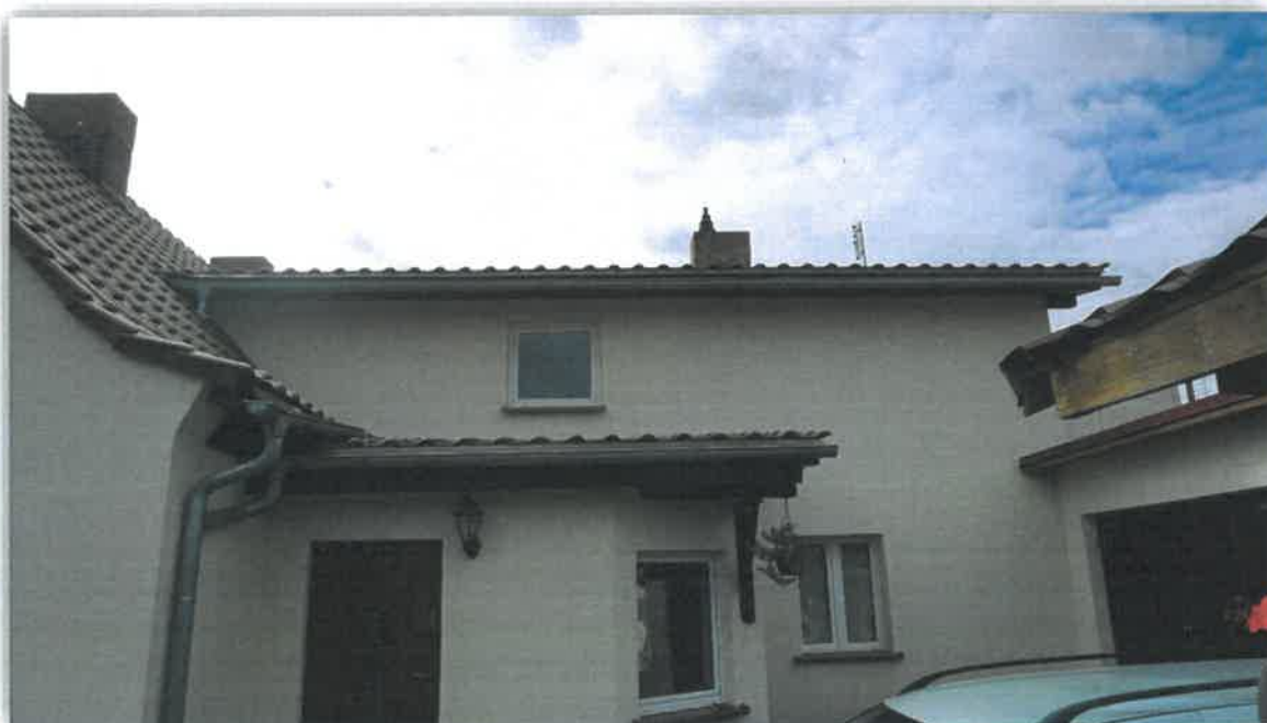
Nielegalna nadbudowa budynku mieszkalnego przy ul. Łąkowej w Bolesławcu – kontrola w wyniku skargi sąsiedzkiej
