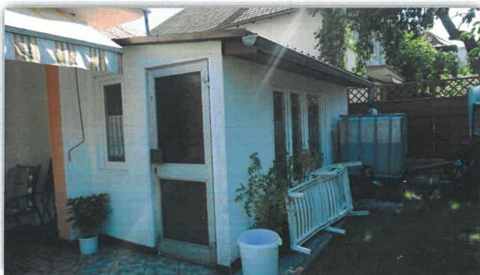
Nielegalnie wybudowana dobudówka przy ul. Narutowicza w Bolesławcu – kontrola w wyniku skargi sąsiedzkiej
