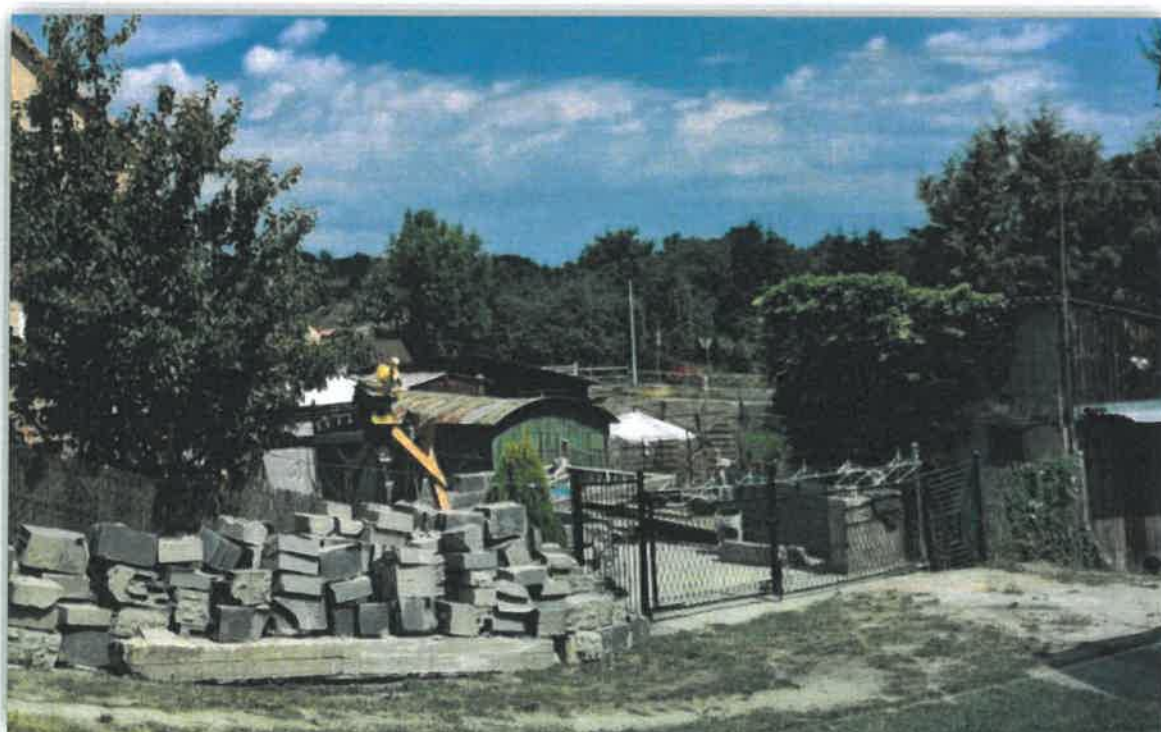
Dokonano rozbiórki powyższego garażu – samowoli budowlanej
