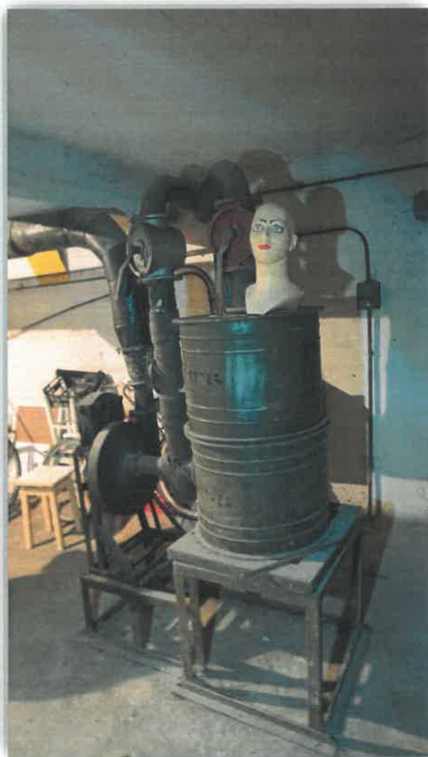
Urządzenie filtrowentylacyjne i zawór przeciwwybuchowy w schronie przy ul. Daszyńskiego 14-15 w Bolesławcu
