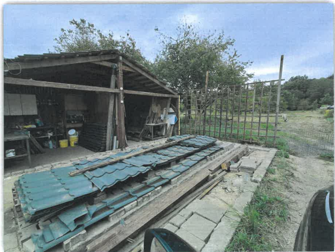
Miejsce po rozbiórce ww. samowoli budowlanej
