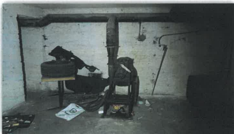
Pozostałości urządzenia filtrowentylacyjnego przy ul. Ogrodowej 2 w Bolesławcu
