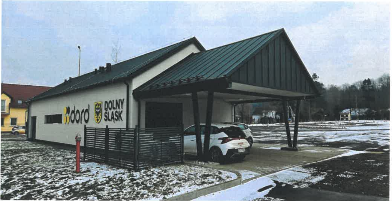
Budynek usługowy ul. Lubańska 75 w Bolesławcu, Dolnośląski Ośrodek Ruchu Drogowego
