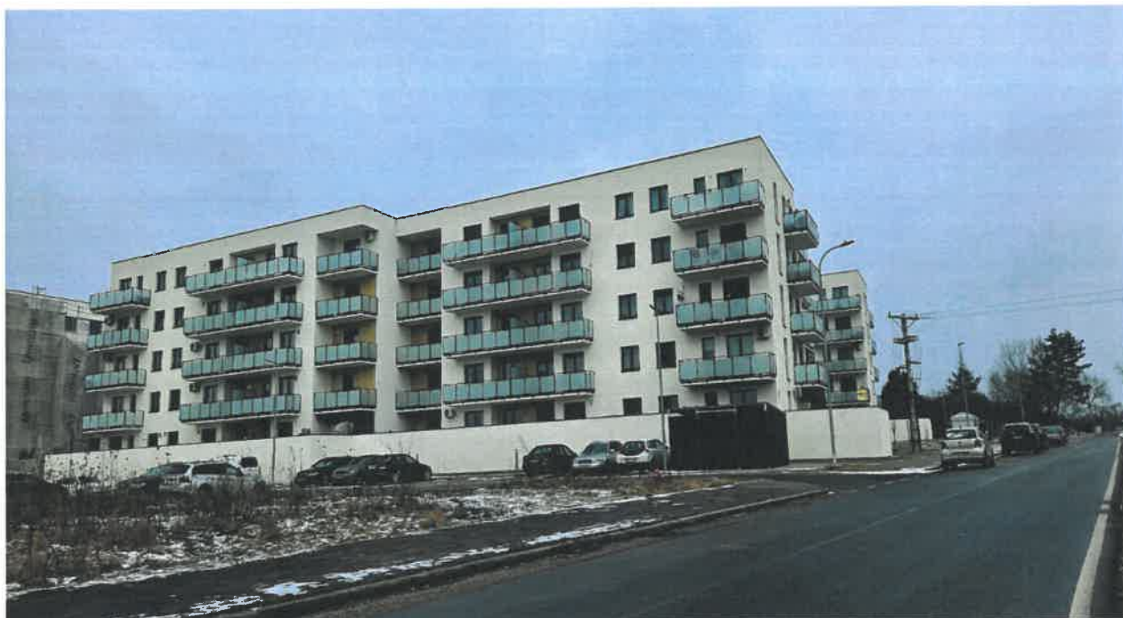
Budynek mieszkalny wielorodzinny z garażem podziemnym ul. Staroszkolna 31A i 31B w Bolesławcu – EXPIRO Sp. z o.o.
