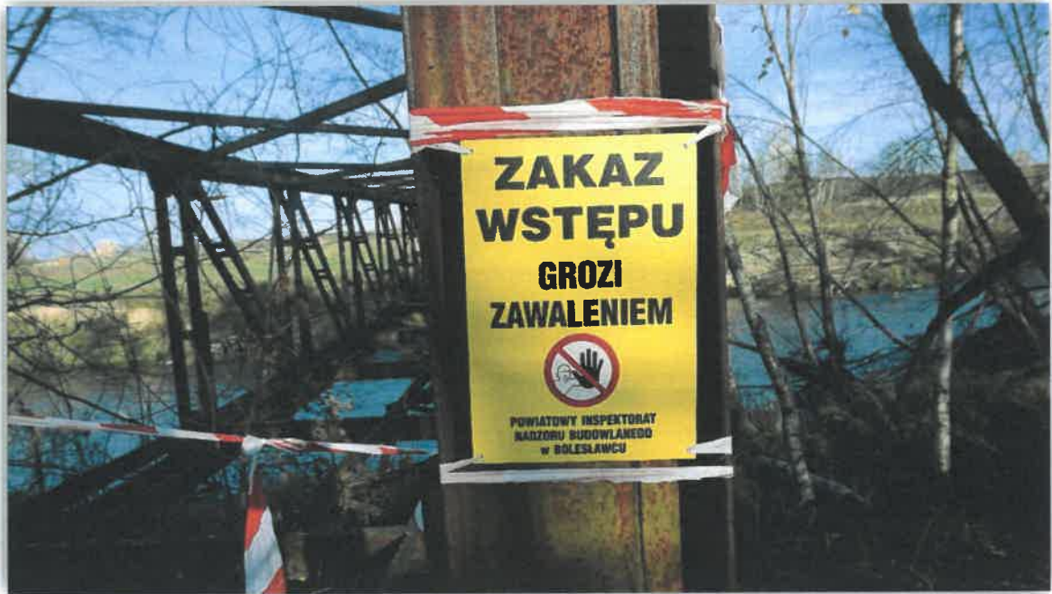
Wygradzenie nieczynnego mostu technicznego byłej żwirowni w Starej Olesznie
