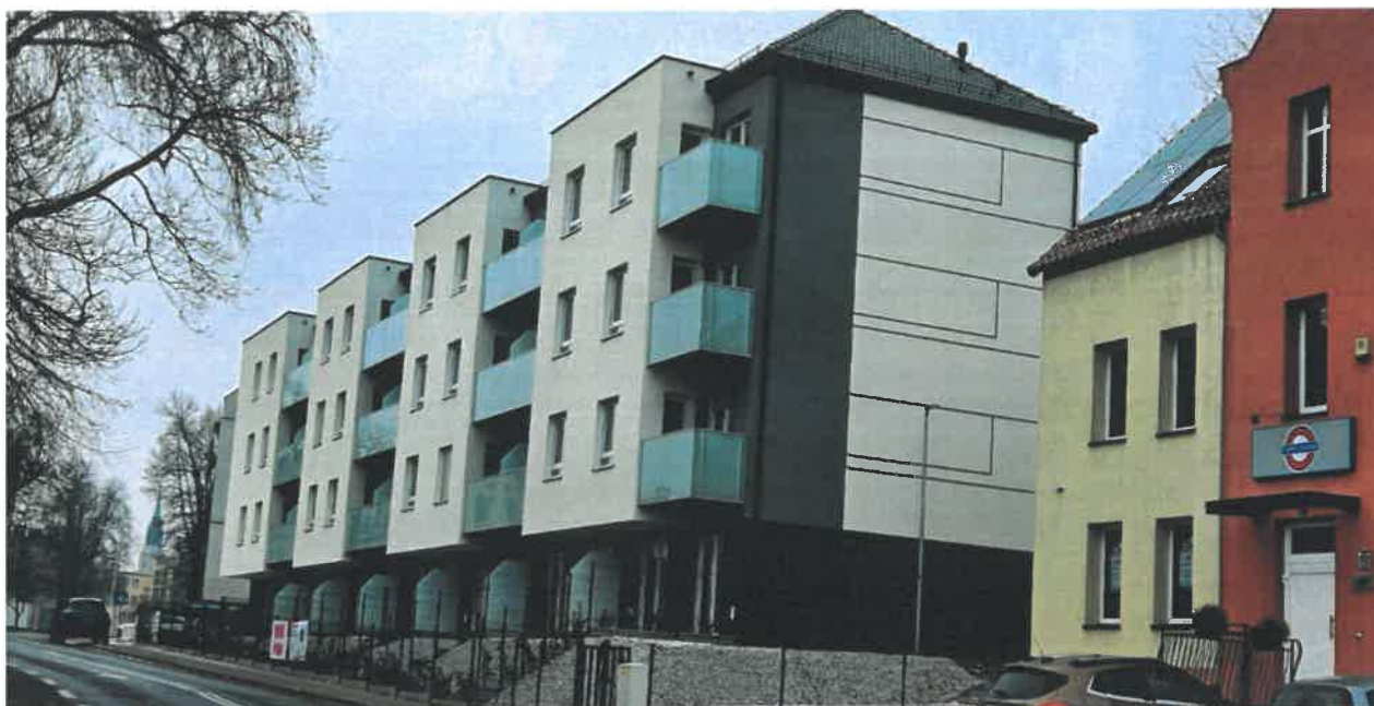
Budynek mieszkalny wielorodzinny przy ul. Polnej 11A- AK INVEST
