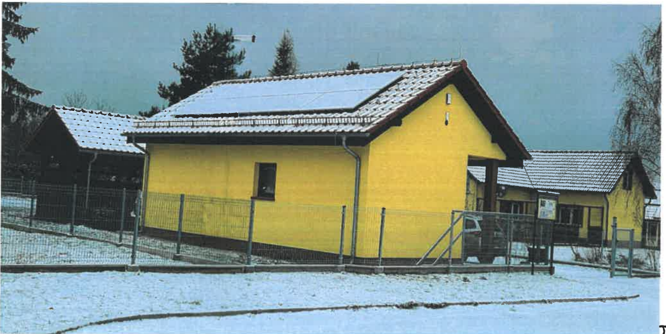
Budynek kancelarii leśnictwa ul. Kasztanowa 8B w Osiecznicy, Nadleśnictwo Węgliniec
