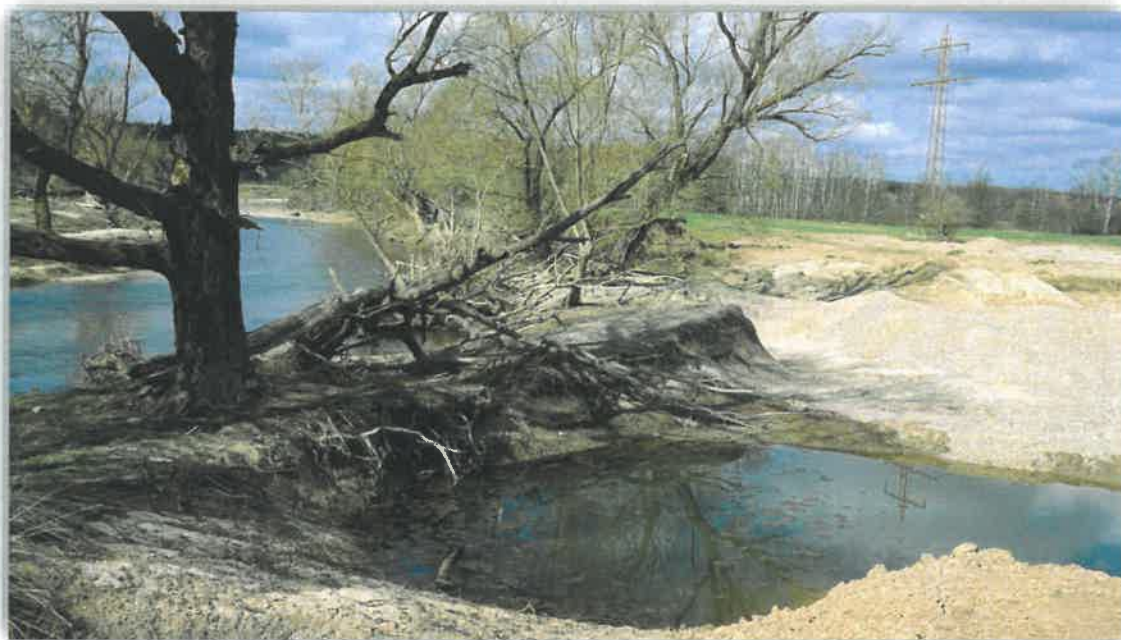
Wał przeciwpowodziowy między Golnicami i Parkoszowem – uszkodzony i po odtworzeniu
