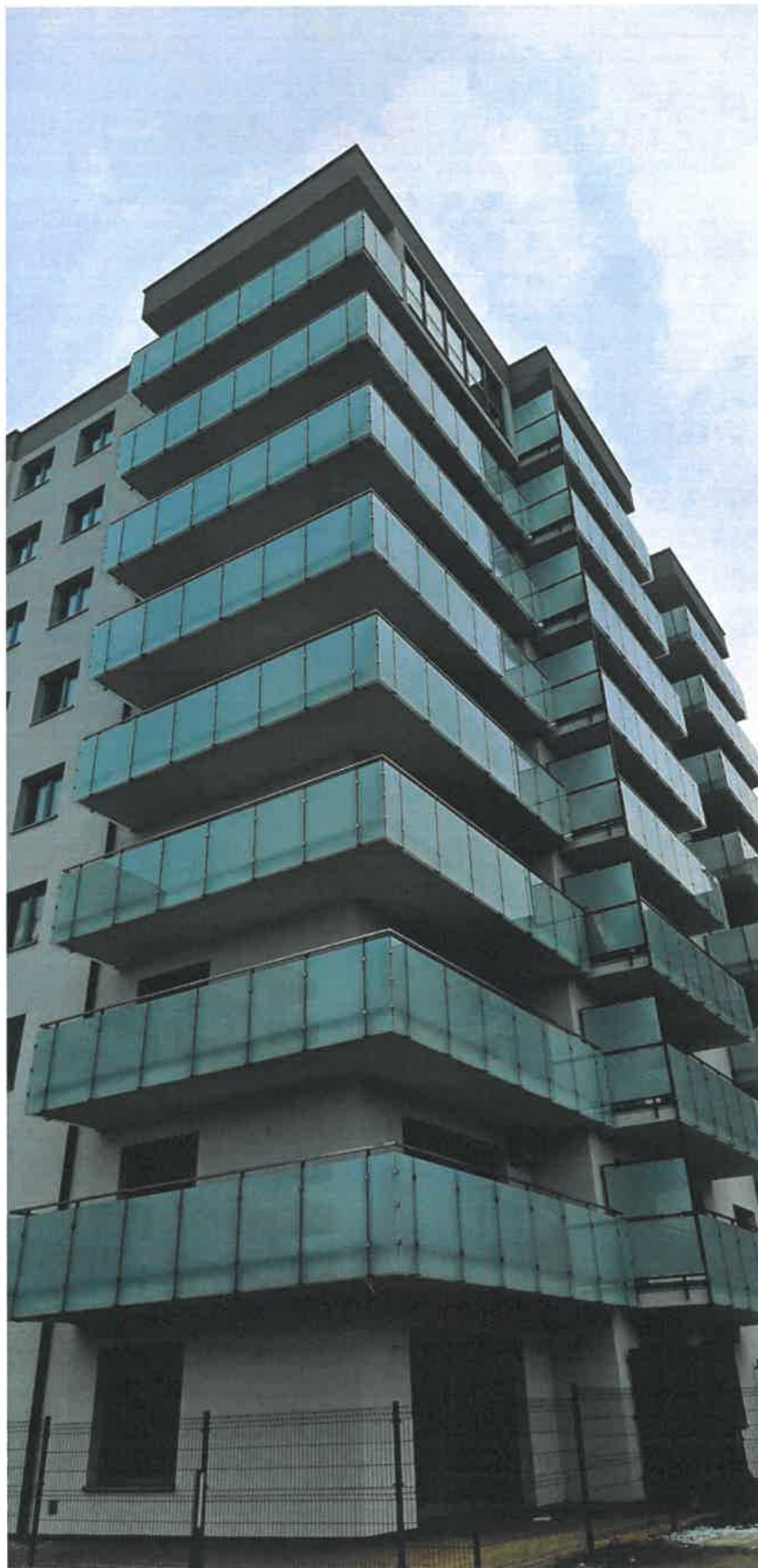
Budynek mieszkalny wielorodzinny przy ul. Hutniczej/Staroszkolnej w Bolesławcu
