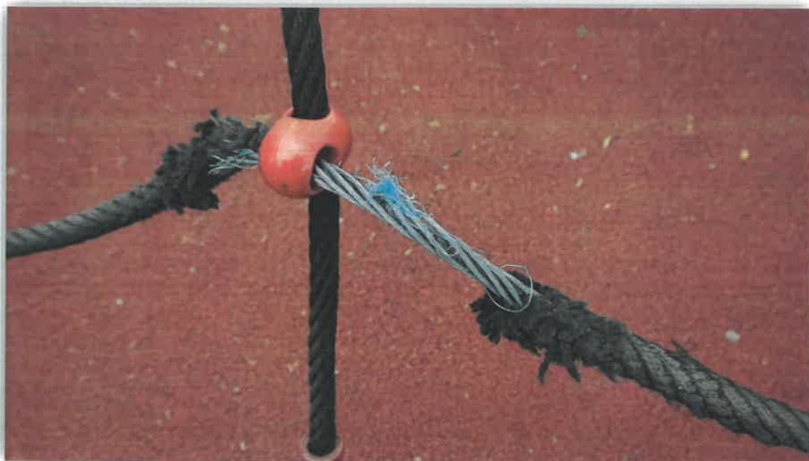
Uszkodzona otulina linki stalowej na linarium na placu zabaw przy Szkole Podstawowej w Tomislawiu
