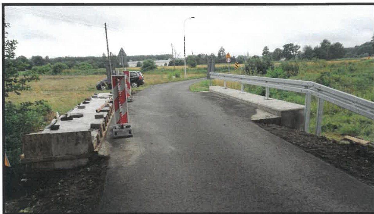
...i w trakcie remontu, po decyzji nakazowej PINB :
