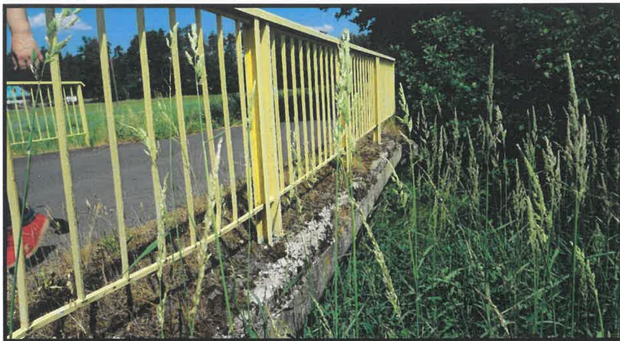
most w miejscowości Bronowiec – przed remontem
