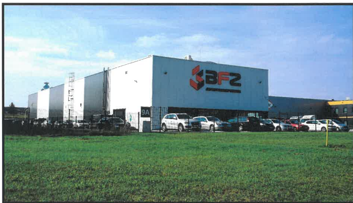
Hala produkcyjna z częścią biurową ul. Przemysłowa nr 9a w Bolesławcu - BFZ Sp. z o.o.
