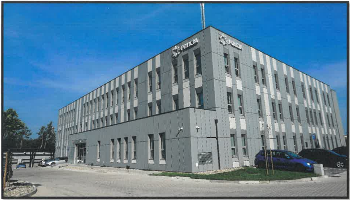
Budynek Komendy Powiatowej Policji ul. Modłowa nr 3 w Bolesławcu
